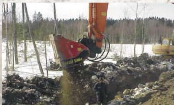
6. Дробление и засыпка промерзшей земли прямо в траншею трубопровода (увеличивает производительность).
