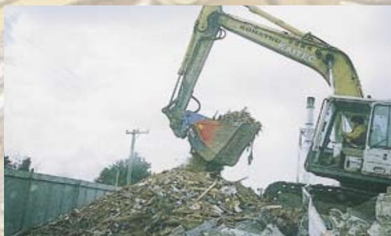
5. Просеивание и дробление строительного мусора или загрязнённой почвы.
